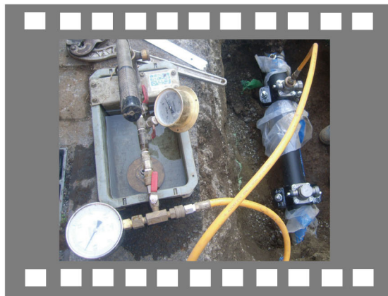
サドル分水栓のテスト現場
