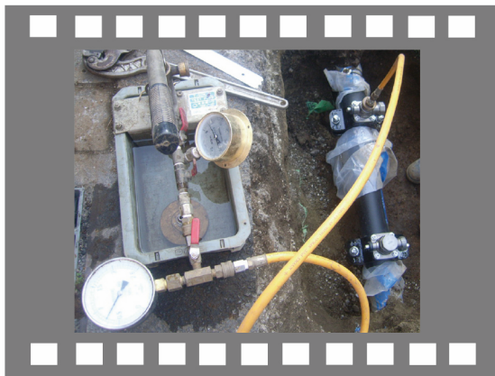
サドル分水栓のテスト現場
