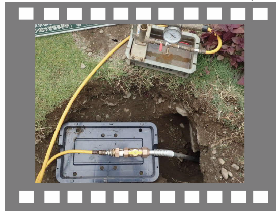
Aバルブからのテスト現場
